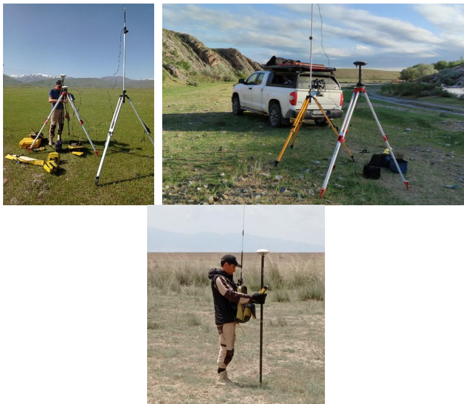
Рисунок 3 - Рабочие моменты проведения изыскательских работ используя GNSS приемников
