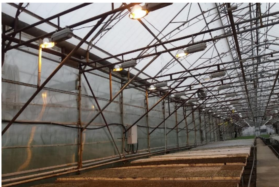
Рисунок 3 – Фасад теплицы из поликарбоната
