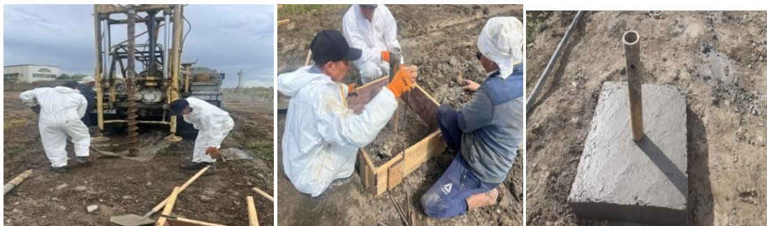
2-сурет. Бақылау ұңғымасын орналастыру жұмыстары.
