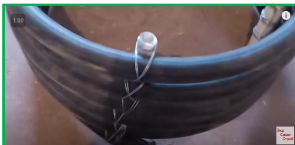
Сурет 3 – Концентрлі шеңбер түріндегі коаксиалды жылу алмастырғыштың төселуі
