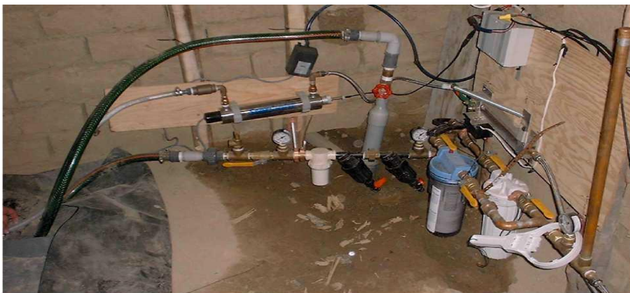
Рисунок 2 – Устройство для обеззараживания воды на основе ультрафиолетовых ламп.
